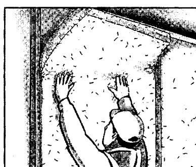
Pentru izolare fonică și termică se fixează cu cleme metalice între profilele portante CW saltele de izolație pe bază de vată minerală.
